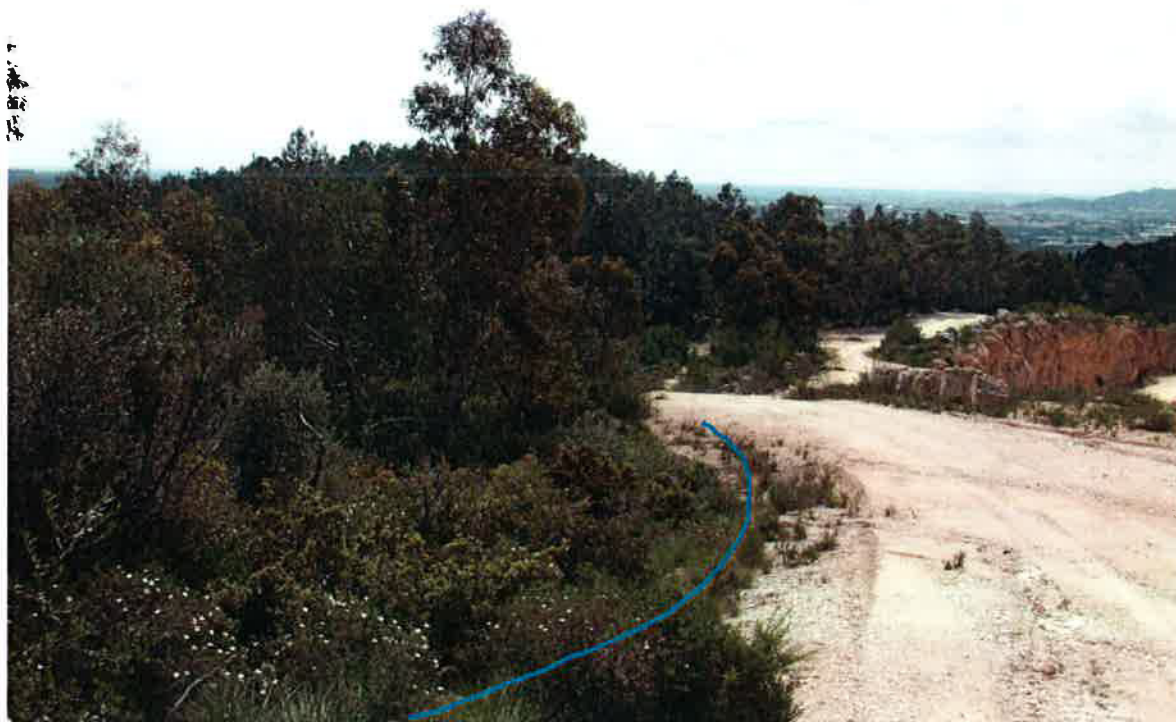
Figura 2 - Vala periférica da rampa.
